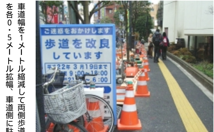
烏山駅前の工事中の駐輪帯
