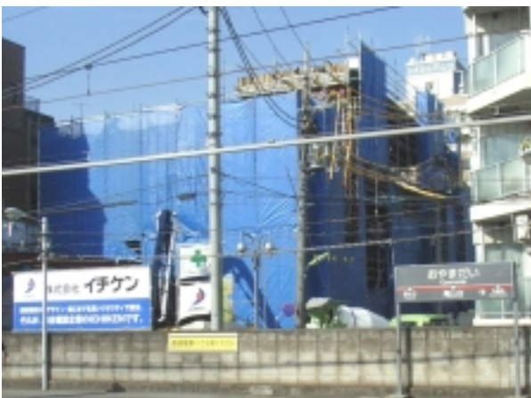
工事中のオオゼキ尾山台店 (3月5日、尾山台駅ホームから撮影)
